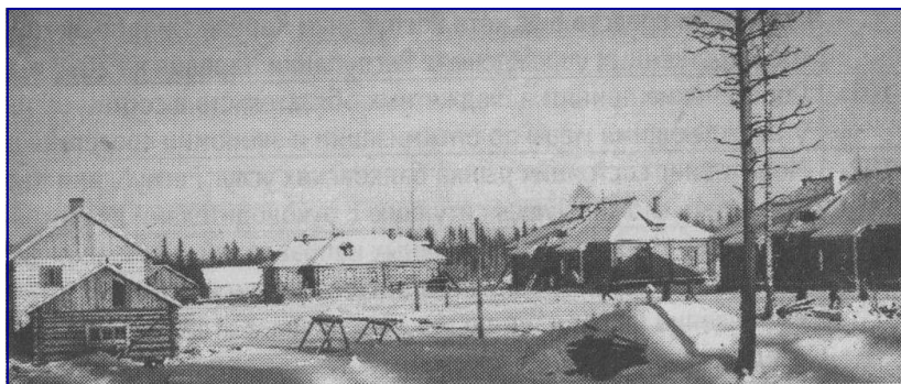
Посёлок финских лесозаготовителей Вилговского лесоучастка Петрозаводского леспромхоза. Посёлок Вилга 1930 год.
